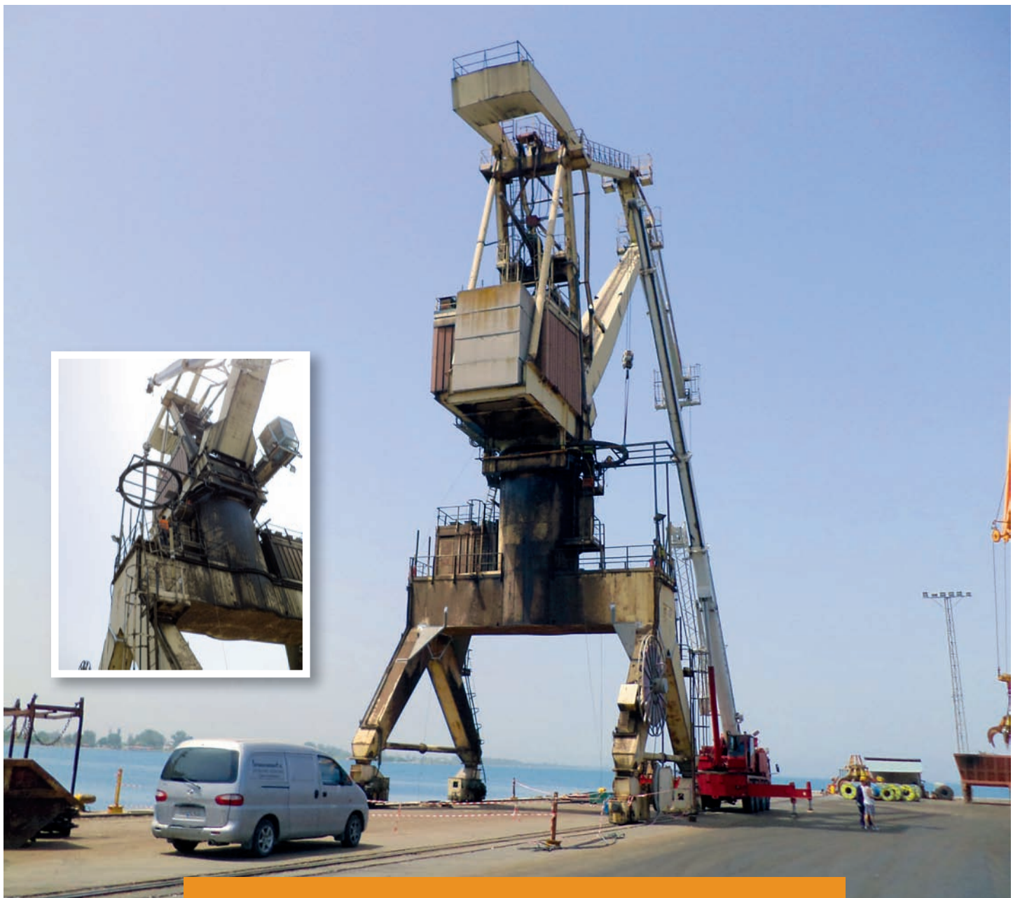
Γερανός Sovel κατά την αφαίρεση του κεντρικού εδράνου περιστροφής
