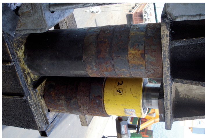
Ανύψωση του περιστρεφόμενου τμήματος (250 τόνων) κατά 420 mm, με γρύλους – τάκους
