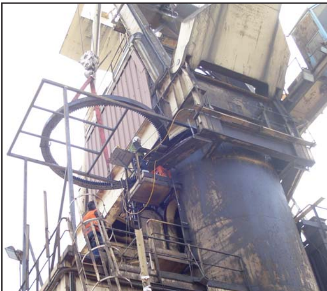
Αντικατάσταση Εδράνου Περιστροφής & Επιτόπια Κατεργασία Φλαντζών Slewing Bearing Replacement & At Site Machining of Flanges
