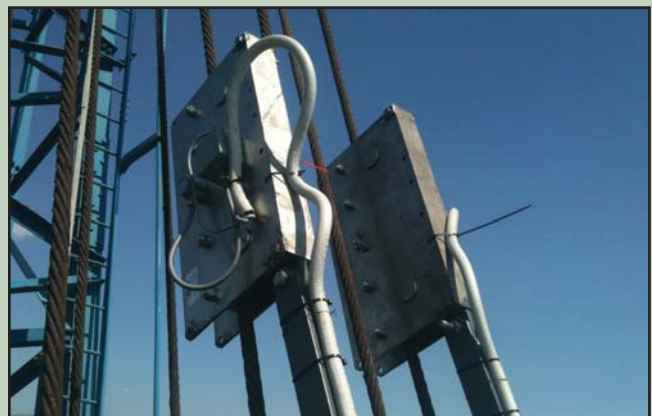
Εγκατάσταση Συστήματος Προστασίας Υπερφόρτωσης Installation of Overload Protection System
